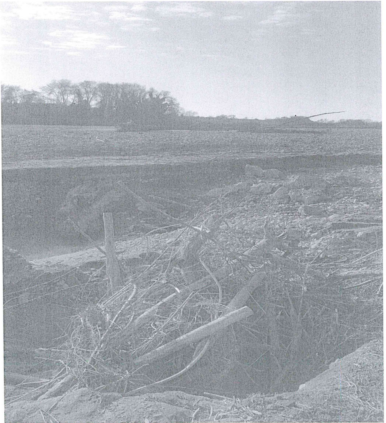
Asportazione di terreno coltivabile e deposito detriti nei pressi del Fiume Fiora
