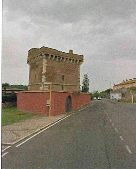
4. STRADA DELLA MARINA DIREZIONE MONTE TORRE DEI MACAZZINI
