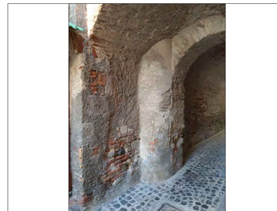
FOTO 5 - Parete interna Nord
