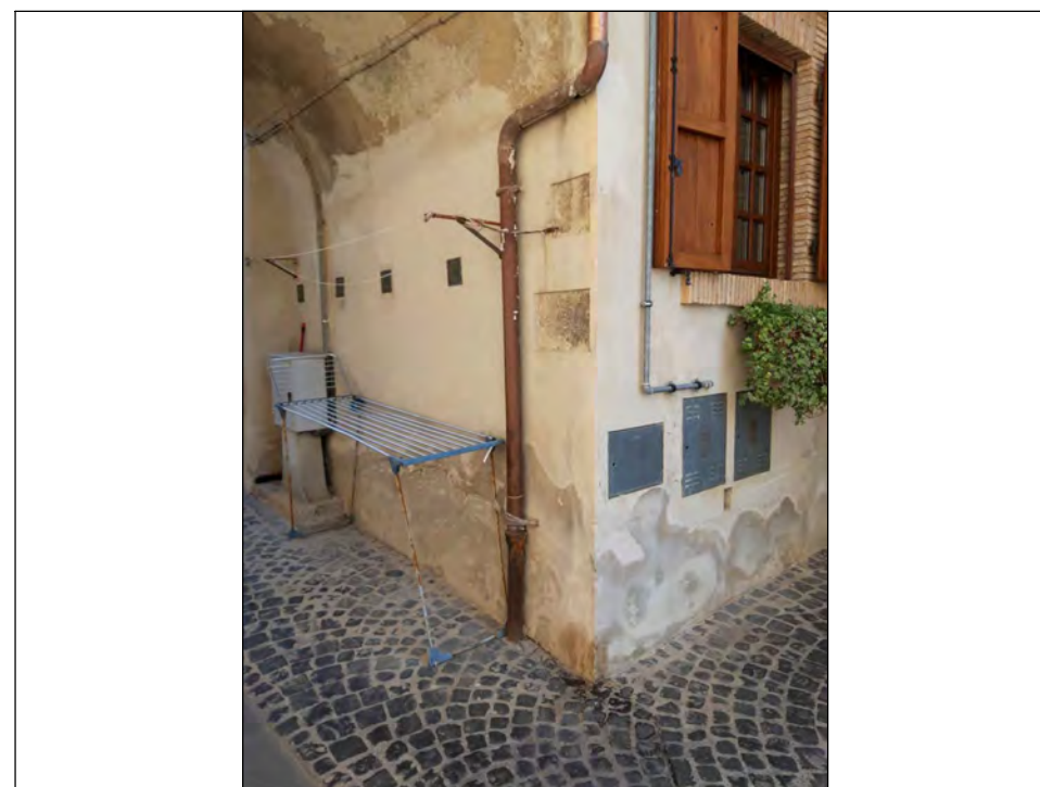
FOTO 3 - parete interna Est
