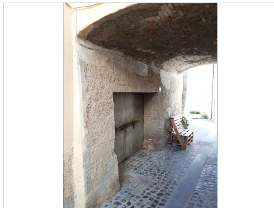
FOTO 3 - parete interna Est
