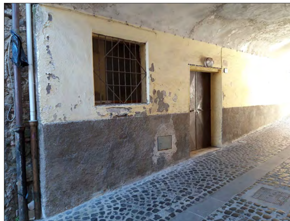
FOTO 3 - parete interna Est
