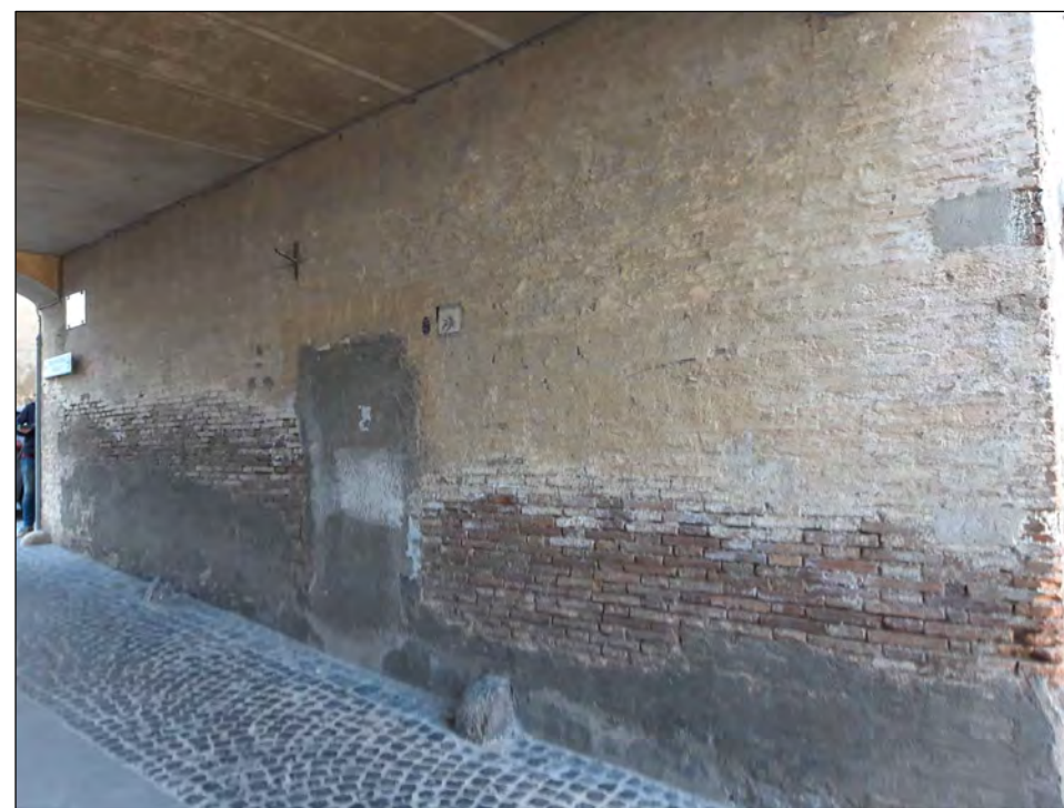
FOTO 3 - parete interna Ovest
