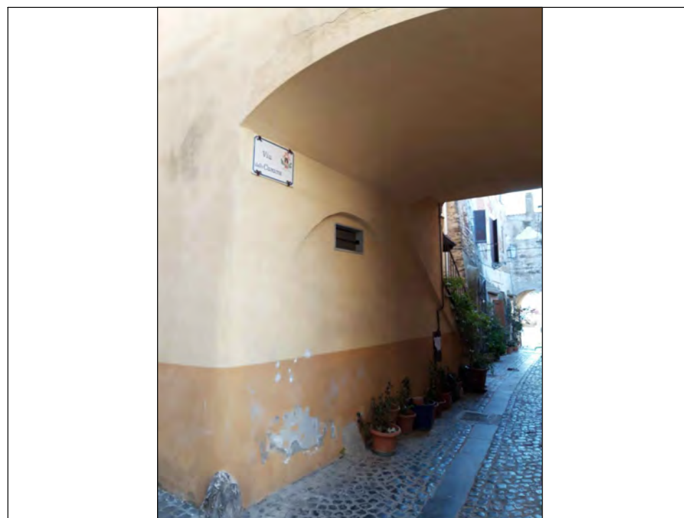
FOTO 3 - parete interna Est
