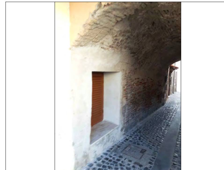
FOTO 7 - Parete interna Sud
