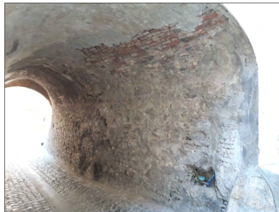
FOTO 4 - parete interna Nord
