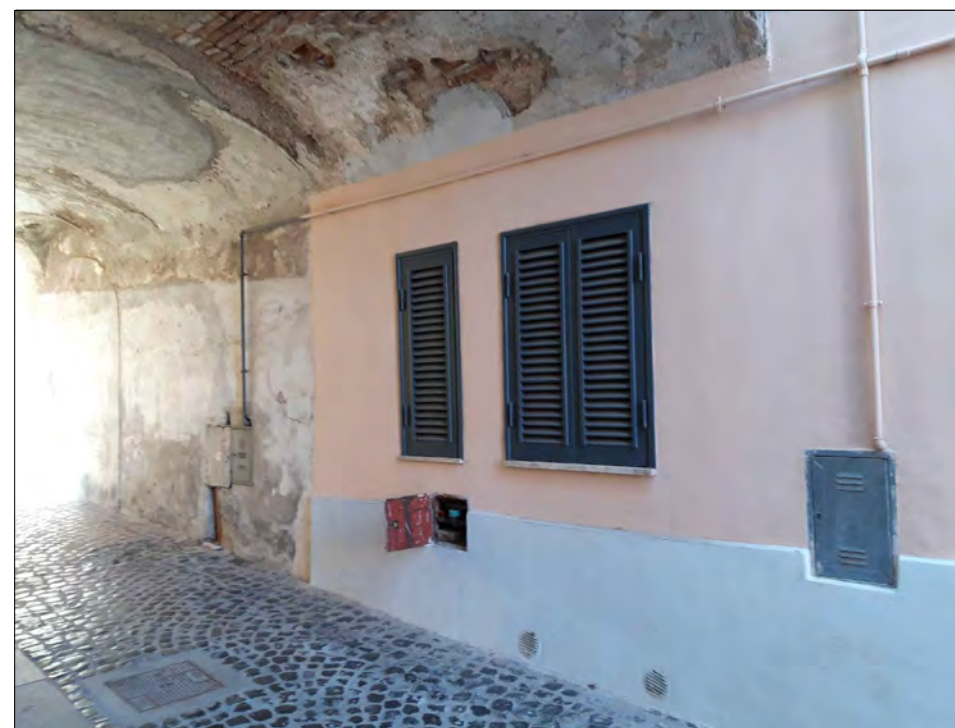
FOTO 4 - parete interna Ovest
