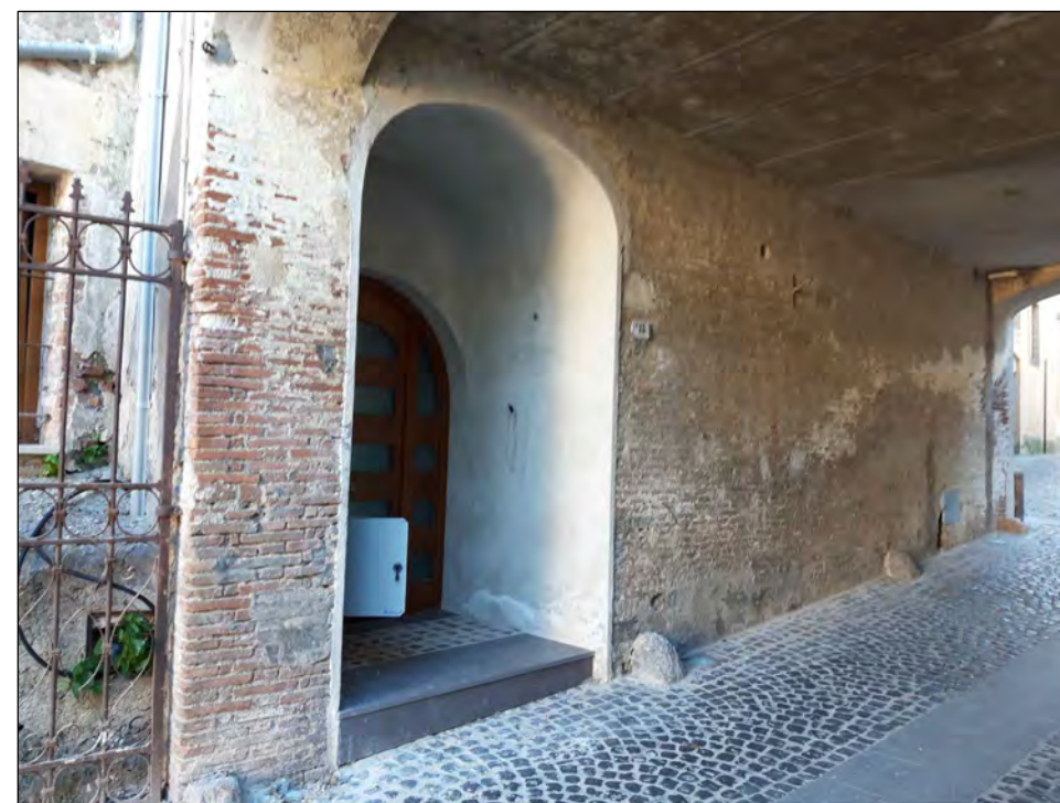
FOTO 4 - parete interna Est
