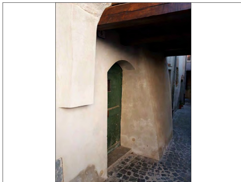
FOTO 3 - parete interna Est
