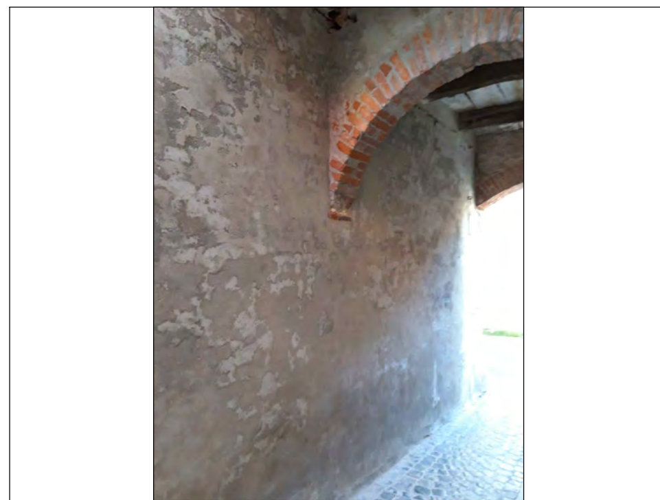
FOTO 3 - parete interna Est
