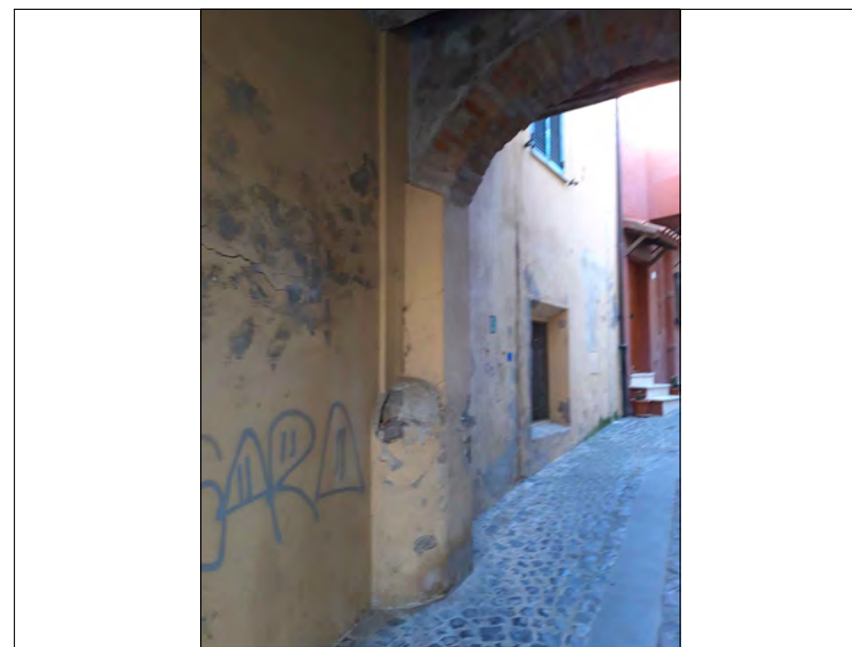
FOTO 4 - parete interna Ovest
