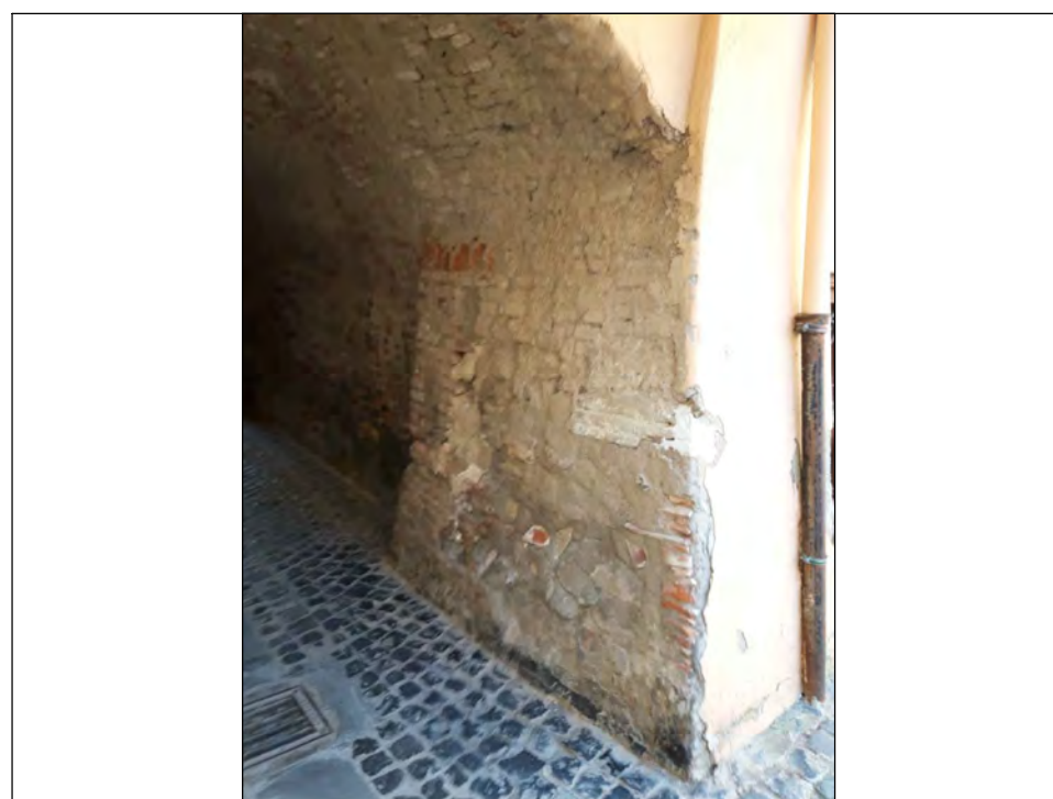
FOTO 3 - parete interna Nord
