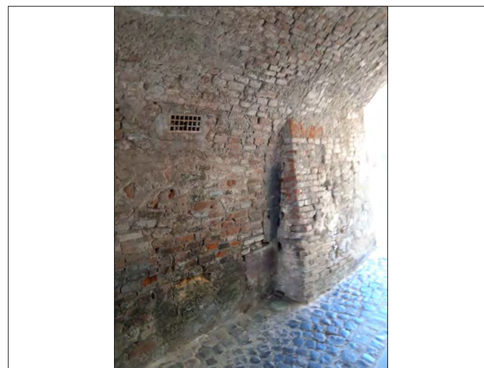
FOTO 4 - parete interna Nord
