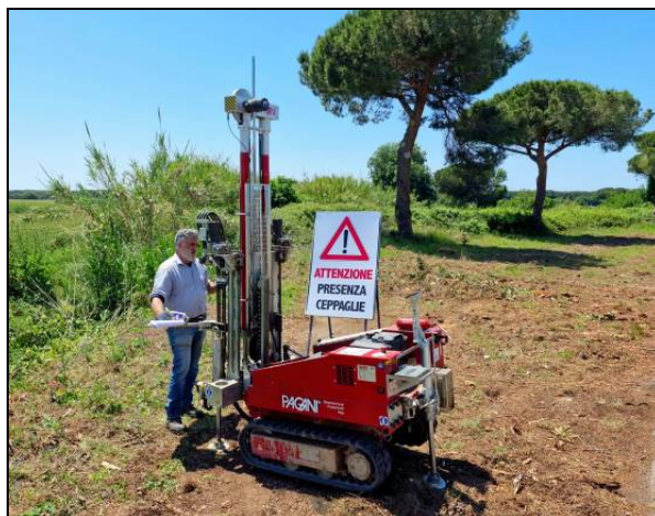
Realizzazione sondaggio penetrometrico S3
